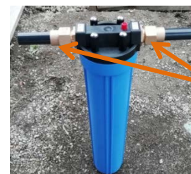
左写真は、ビニル管用伸縮継手（エラスジョイント）
